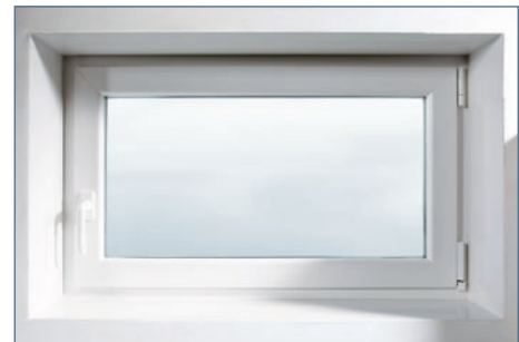
Nach der Renovierung
