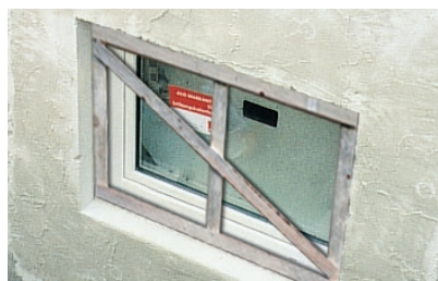
5. Die Stützkreuze verbleiben bis zum Abschluss der Rohbauphase zum Schutz vor Beschädigungen in dem Leibungsfenster.
